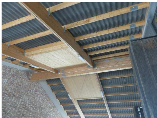
Figur 24. Utrymmen för fladdermöss i taket på det nybyggda ridhuset.
