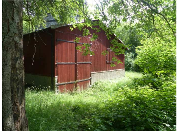
Figur 22. Kalkugn med intilliggande redskapsbod, Klagshamn.
