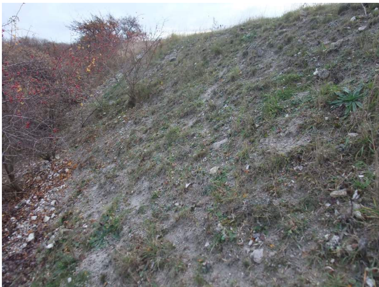
Figur 22. Lerig slänt söder om Luftkastellet på Lernacken, med förekomst av smal toffelmossa. 2018-11-25
